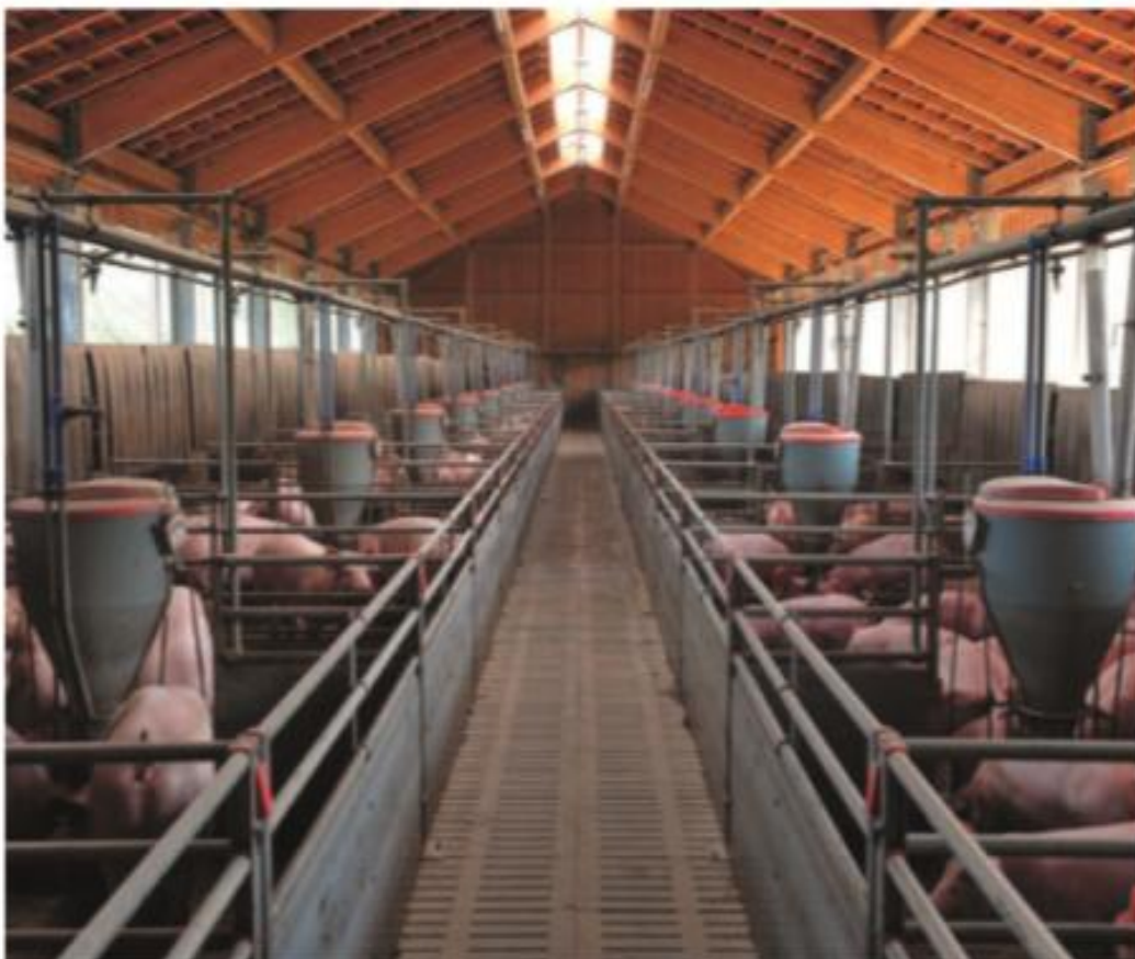
Schweinemastanlage mit Rutschen in zwei Reihen, Spaltenboden, Futterautomaten an Rohrsystem und großen Fensterflächen
